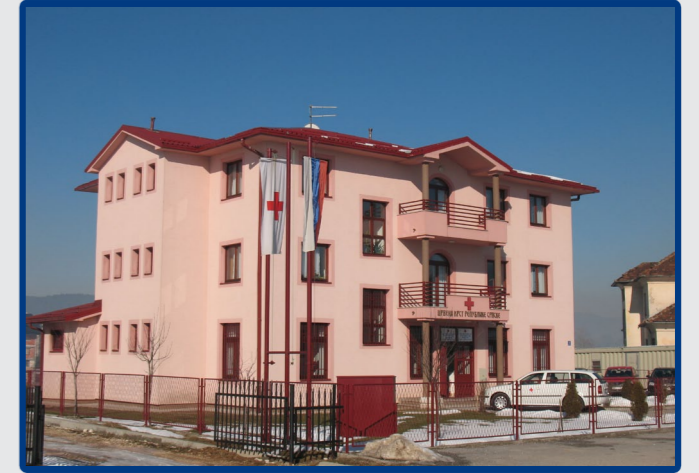
Upravna zgrada Crvenog krsta RS, Pale
