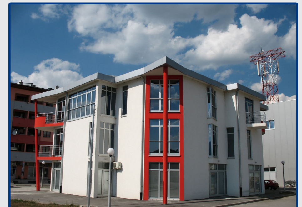
Upravna zgrada Marvel, Istočno Sarajevo
